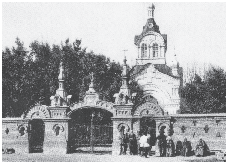
Главный вход и часовня Вознесенского кладбища. г. Благовещенск, 1912 г. (не сохранились)
